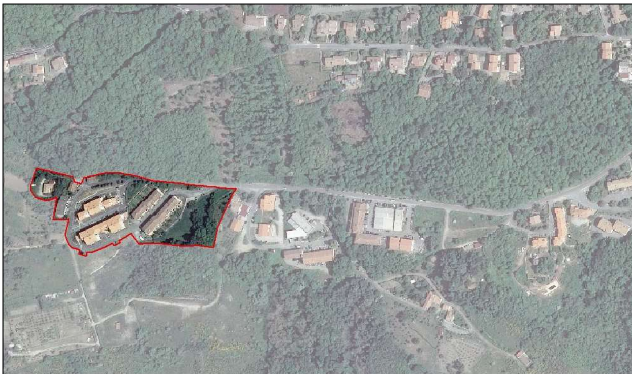
Capoluogo. Tessuti urbani di formazione recente. Espansione sud: l'intervento PEEP all'estremità occidentale dell'abitato. Ortofoto 2010, scala 1:5.000.
